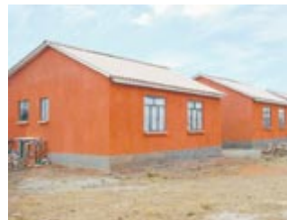
CASAS DEL PLAN Algunas viviendas que fueron edificadas hace un tiempo por el programa gubernamental en la urbanización Cristal, en El Alto, camino a Senkata.
