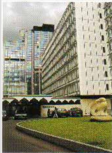
Fig. 5. Seu de la UNESCO a París. Un altre dels edificis emblemàtics on s'han fet treballs de desamiantatge.
